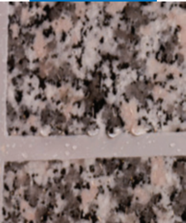
Герметизация швов в натуральном камне
