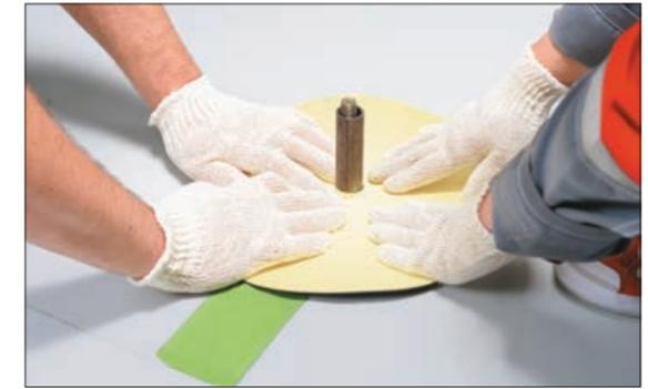
8. Затем быстро, пока мембрана не остыла, наденьте заготовку на проходку малого диаметра.
