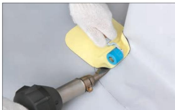
7. Доварите шов. Для продавливания толстой неармированной мембраны желательно использовать жесткий тефлоновый ролик. Другую сторону элемента приварите аналогично.
