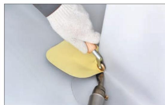
5. Особенно тщательно проварите стык мембран узким латунным роликом для гарантии водонепроницаемости угла.
