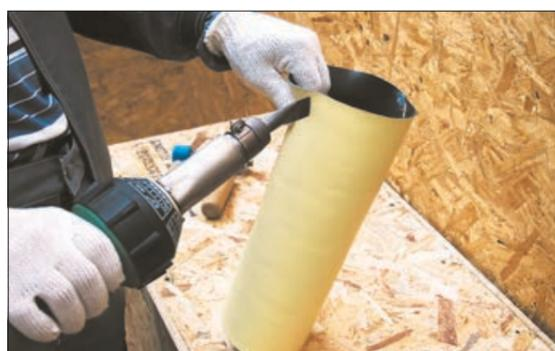
12. Разогревайте феном небольшой участок нижней части заготовки, пока мембрана в этом месте не станет пластичной.
