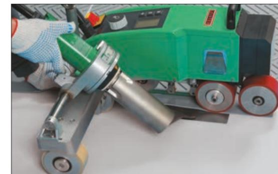
4. После сборки пешеходной дорожки в ряд приварите элементы к мембране, используя автоматическое сварочное оборудование. Для приваривания к кровле предусмотрены специальные полосы без тиснения вдоль краев элемента.
