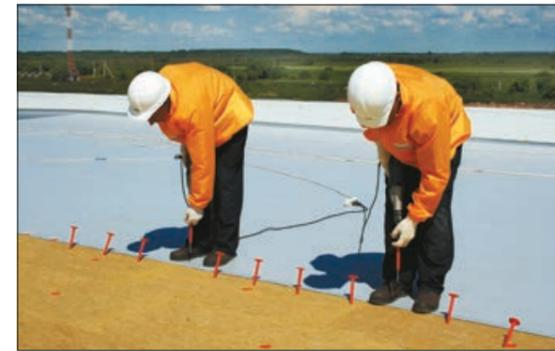
Рис. 5.4.4 Механическое крепление мембраны
