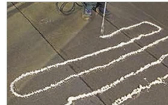
2. Наносите клей-пену полосами, оптимальное расстояние между полосами — 300 мм. Примерно через 10 минут после нанесения, когда закончится процесс поднятия и стабилизации пены, можно начинать укладку плит LOGICPIR.
