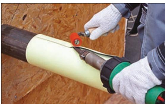
11. Проварите нахлест ручным феном, прикатывая тефлоновым или силиконовым роликом. Для облегчения работы (особенно в случае большого количества труб одинакового диаметра) можно использовать для сварки шва горизонтальную вспомогательную трубу. Снимите фаску с мембраны на нижней части заготовки.
