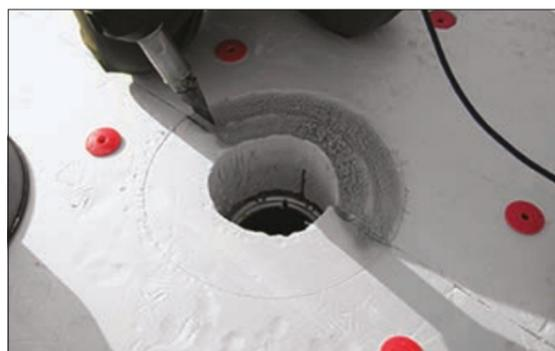
4. Сделайте в плитах отверстие для воронки. Для плотного прилегания фланца воронки «снимите» фаску, например, подплавляя XPS с помощью ручного фена.
