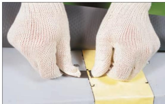
10. Снимите фаску по краям куска неармированной мембраны на величину сварного шва (не менее 30 мм).
