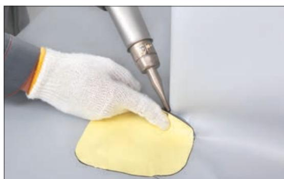
10. Приваривайте угол заготовки, нажимая пальцем, пока элемент полностью не будет приварен.
