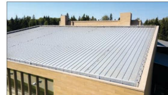
Рис. 4.8.2 Вид мембранной кровли с имитацией фальца
