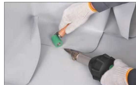
11. Далее приварите нахлест мембраны к основному кровельному ковру обычным образом с помощью силиконового ролика.
