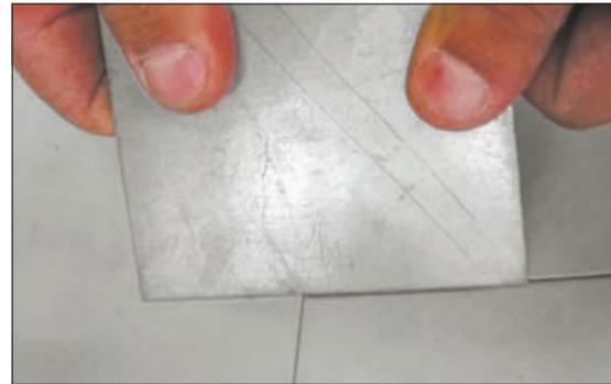
Рис. 5.2.15 Фиксация Т-образного шва металлической пластиной
