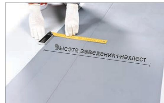
1. Ширина полосы = высоте заведения мембраны на парапет (либо длине мембраны, нужной для «оборачивания» парапета) + размеру нахлеста мембраны на горизонталь (не менее 150 мм). Подготовьте также узкую полосу армированной мембраны V-RP шириной 120 мм для изготовления «кармана».
