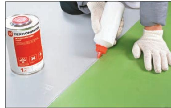
Рис. 3.4.2 Обработка стыка жидким ПВХ
