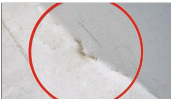
Рис. 3.6.8 Возможное повреждение мембраны при классическом способе крепления к вертикальной поверхности
