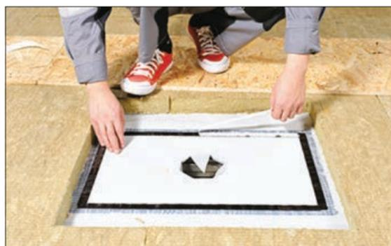
3. В случае использования одноуровневой воронки рекомендуется наклеить на пароизоляционную пленку бутил-каучуковую ленту по периметру листа усиления. Плиты XPS во время монтажа площадки плотно прижмите к ленте.
