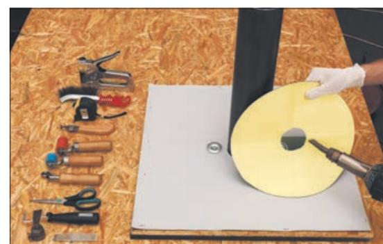
3. Нагревайте заготовку с обеих сторон вокруг отверстия с помощью фена до тех пор, пока мембрана не станет пластичной. Для облегчения надевания заготовки на трубу можно растягивать внутреннее отверстие пальцами.
