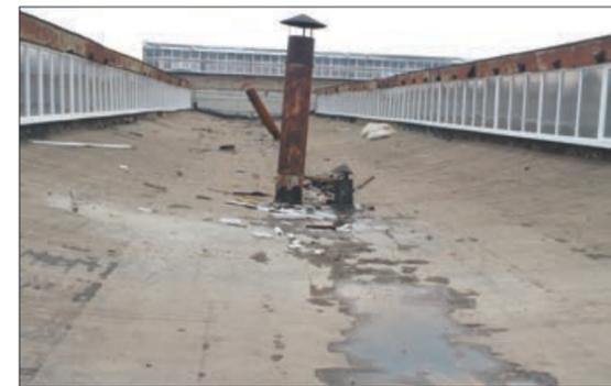
Рис. 2.10.3 а, б Старая битумная кровля
