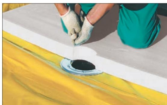
2. Для получения ровного твердого основания вокруг воронки, чтобы избежать проваливания воронки, используйте плиты XPS. Желательный размер такой площадки не менее — 1×1 м.
