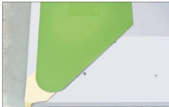
8. Закруглите угол полосы с помощью ножниц и подрежьте торец под углом 45°.
