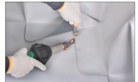
10. Приварите шов в месте перехода из «конверта» внахлест мембраны при помощи латунного ролика.
