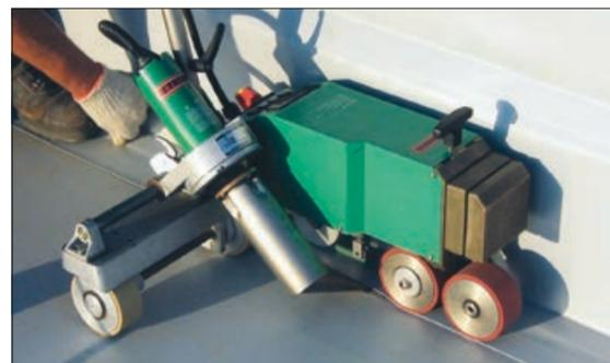
Основная инновация, связанная с полимерными мембранами, относится к технологии сварки горячим воздухом. В отличие от других методов, например, использования клея, растворителей, газовых горелок, эта технология гарантирует гомогенное соединение и полностью герметичную поверхность кровли. Полученный сварной шов более прочный, чем сама мембрана.
