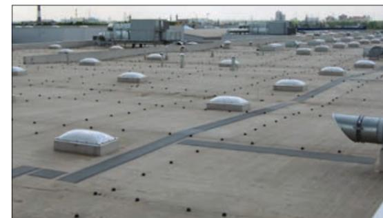
Рис. 3.6.4 Вид кровли с применением пешеходной дорожки ТЕХНОНИКОЛЬ
