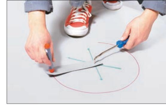
12. Продолжайте укладку мембраны в зоне установленной воронки обычным образом. После закрепления полотна найдите на мембране центр воронки как точку пересечения двух отрезков между гайками на фланце.
