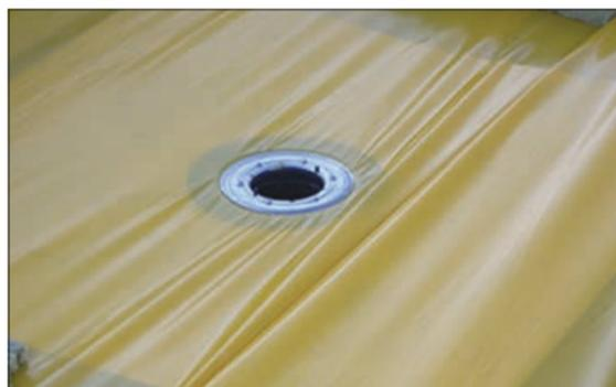
1. Желательно использовать двухуровневую воронку. Нижний фланец воронки позволяет надежно зажать пароизоляционную пленку для обеспечения сохранения пароизоляционной функции в месте проходки сквозь пленку.
