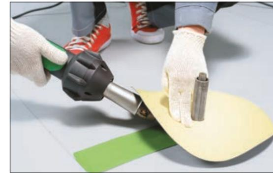
9. Прихватите заготовку точно в нескольких местах. Снимите фаску с краев заплатки на величину сварного шва (не менее 30 мм).
