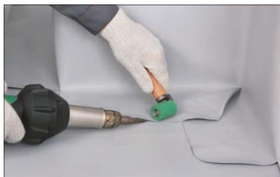
14. Далее приварите нахлест мембраны к основному кровельному ковро обычным образом с помощью силиконового ролика.
