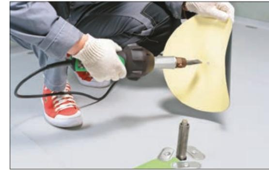
7. Прогревайте заготовку горячим воздухом, равномерно водя феном вокруг отверстия, пока мембрана в месте прогрева не станет пластичной.
