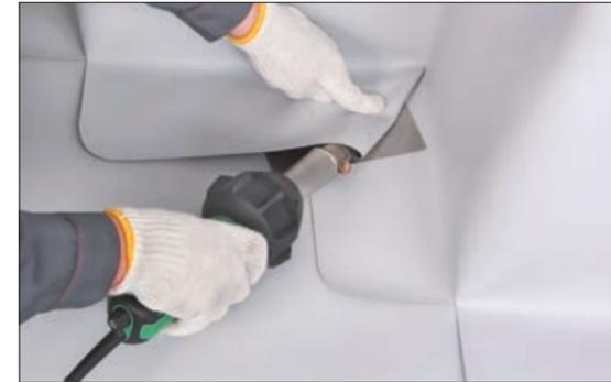
7. Для избежания повреждения нижних слоев материала подложите под петлю из мембраны металлическую пластину с обработанными краями толщиной 0,3-0,5 мм из оцинковки или нержавеющей стали и сделайте прихватку.
