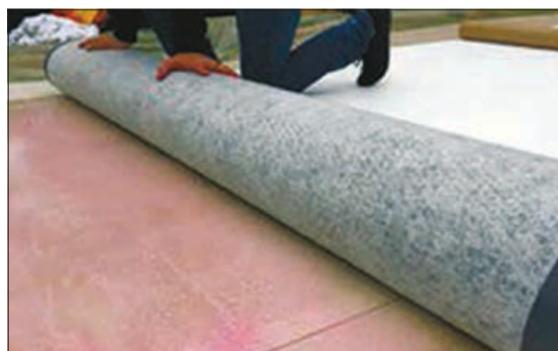
6. Закатывайте мембрану с флисом на участок с нанесенным клеем. Следите, чтобы клеевой состав не попадал в зону сварного шва.
