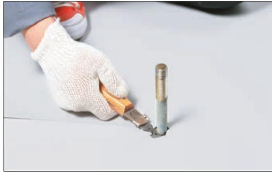
1. Сделайте разрез полотна мембраны, чтобы обойти проходку малого диаметра.
