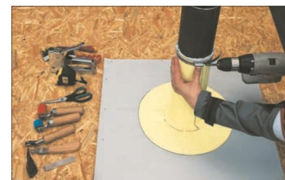
16. Затяните место примыкания металлическим хомутом. Проверьте качество выполненных сварных швов пробником.
