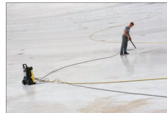
Рис. 2.9.5 – Рис. 2.9.6 Подготовьте старое основание: очистите, обеспыльте, просушите
