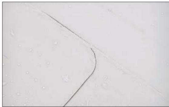
Рис. 5.4.1 Скругление углов мембраны
