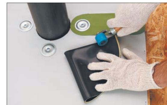
2. Сложите заготовку пополам и прикатайте место сгиба роликом. Затем сложите вчетверо и прикатайте место сгиба. Отрежьте верхнюю часть заготовки ножницами так, чтобы получилось внутреннее отверстие на 50 мм меньше диаметра трубы.
