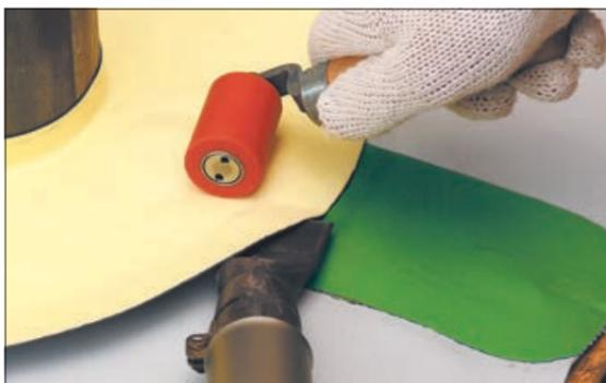
7. Окончательно приварите заготовку по внешнему краю. Проверьте качество сварки с помощью пробника.
