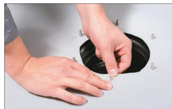
7. Возьмите кусок мембраны LOGICROOF V-RP размером 1×1 м, приложите к воронке и сделайте надрезы ножом в местах установки шпилек, а затем наденьте мембрану на шпильки. Для удобства работы можно использовать готовый фартук из мембраны.
