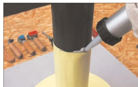
15. Заполните примыкание готового элемента к трубе полиуретановым герметиком ТЕХНОНИКОЛЬ.
