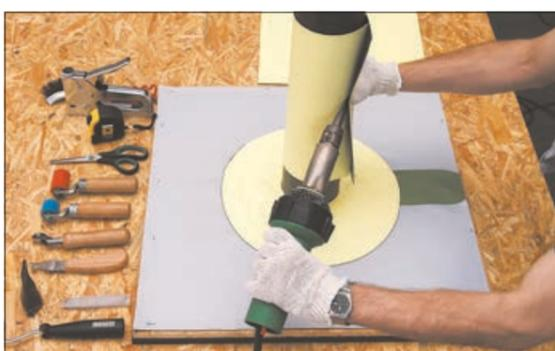
9. Оберните заготовку вокруг трубы, притяните ее пальцами и прихватите в нескольких местах внутри нахлеста с помощью ручного фена. Используйте узкую насадку шириной 20 мм. Для облегчения снятия заготовки с трубы предварительно вложите между ними полосу мембраны.
