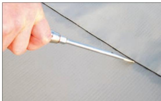
Рис. 5.2.8 Контроль при помощи плоскошлицевой отвертки
