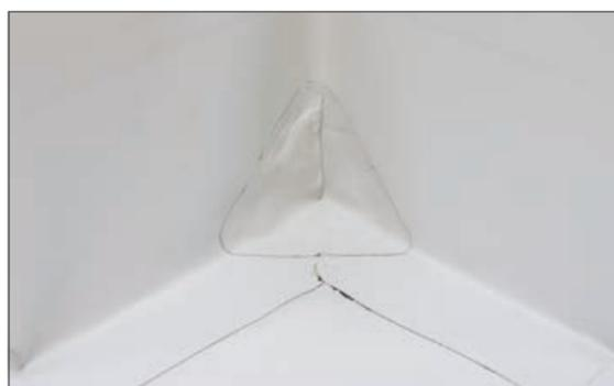
9. Привариваем полученный накладной угол по месту, располагая стык на вертикальном участке угла.
