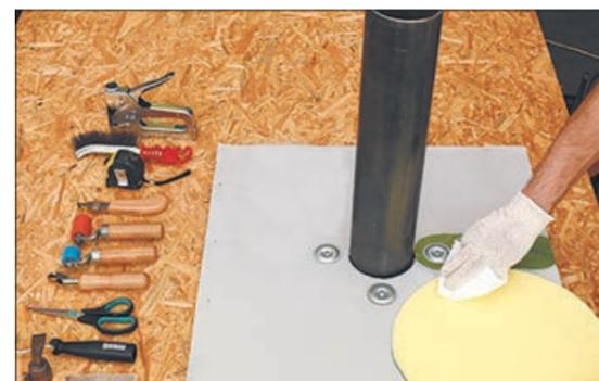
1. Вырежьте круглую заготовку из неармированной мембраны V-SR (условно показана желтым цветом) таким диаметром, чтобы на 40 мм перекрывать установленный крепеж.
