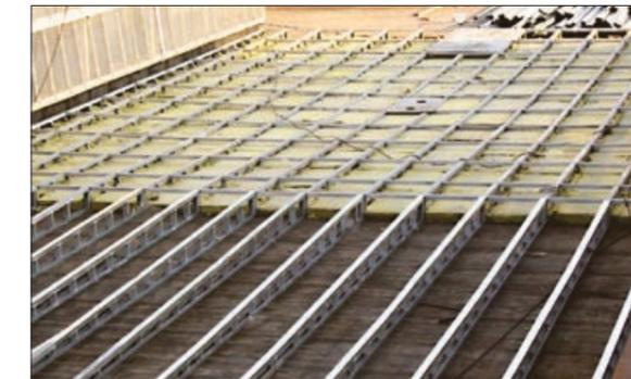
Рис. 3.3.3 Вариант устройства разуклонок
