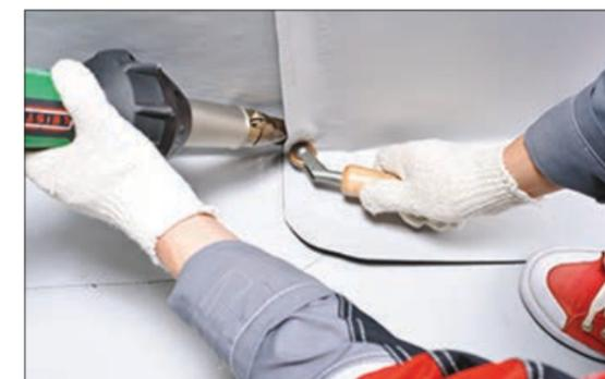
18. Приварите все нахлесты. На горизонтали предварительно снимите фаску с края нижней мембраны.
