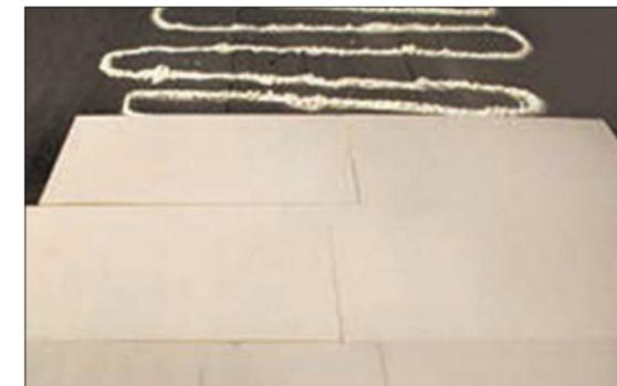
4. Оптимальный вариант — вести работу захватками, постепенно нанося пену и закрывая ее плитами LOGICPIR.
