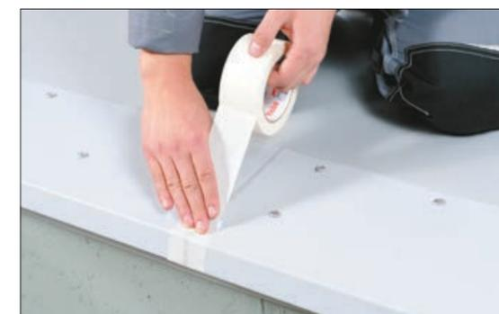
4. На зазор наклейте малярный скотч, чтобы предотвратить заваривание зазора ПВХ мембраной.
