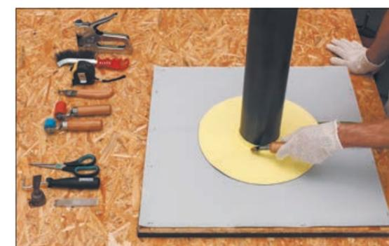
4. Не давая заготовке остыть, быстрым движением с силой наденьте ее на трубу и прикатайте основание «юбки» латунным роликом.
