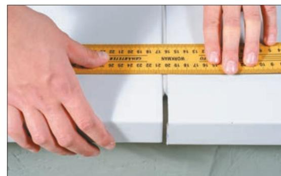
3. Оставляйте температурный зазор через каждые 3 м. Величина зазора должна составлять 3-5 мм. Выставив зазор, закрепите следующий капельник.
