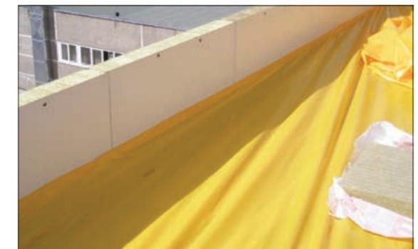
Рис. 3.1.5 Укладка пароизоляционной пленки ТЕХНИКОЛЬ
