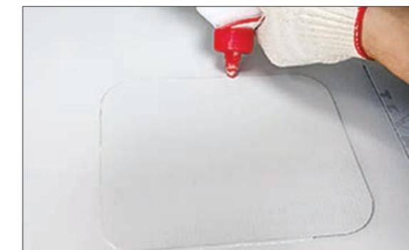
4. Для обеспечения дополнительной надежности от механических воздействий нанесите жидкий ПВХ ТЕХНИКОЛЬ по контуру заплатки.
