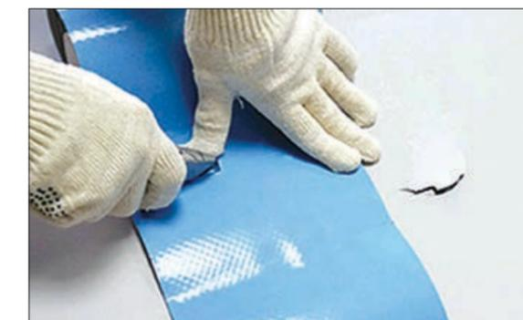
2. При необходимости ножницами вырежьте заплатку нужной формы. Закруглите углы заплатки. Она должна перекрывать место повреждения не менее чем на 35 мм во все стороны.
