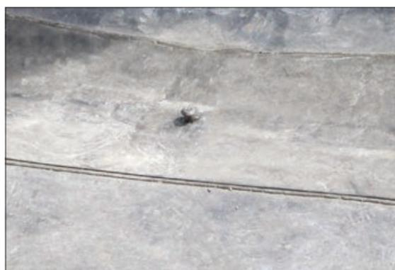
Рис. 3.5.10 Повреждение мембраны шляпкой самореза при применении тарельчатого металлического держателя по минераловатному утеплителю
