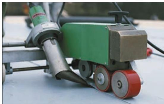
Рис. 5.2.1 Процесс автоматической сварки
