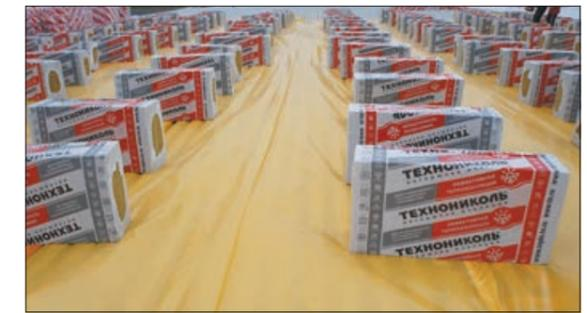
Рис. 3.1.4 Укладка пароизоляционной пленки ТЕХНИКОЛЬ
