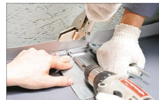
6. Вставьте прижимную рейку в «скрытый карман» и натяните мембрану «кармана» с помощью «зажима кровельщика», одновременно давя на рейку плоскогубцами. При креплении подкладывайте под крепеж металлическую пластину, чтобы избежать повреждения мембраны.
