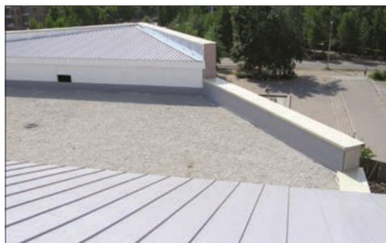
Рис. 2.7.1 Вид балластной кровли
