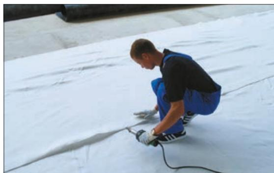
Рис. 3.3.1 Сварка полотнищ геотекстиля между собой
