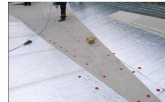
Рис. 3.3.16 Изображение разуклонки в ендове между воронками
