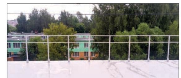
Рис. 4.8.20 Смонтированное кровельное ограждение ТЕХНОКОЛЬ
