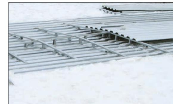
Рис. 3.3.4 Вариант устройства разуклонок
