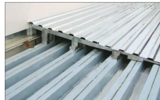
Рис. 3.3.7 Устройство контруклона с помощью подконструкции из профиля с укладкой поверх профлиста
