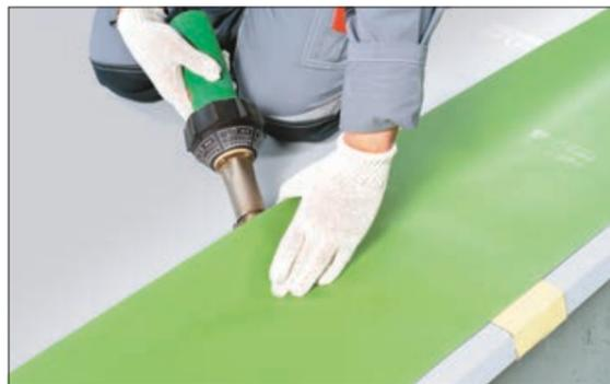
7. Вырежьте полосу армированной мембраны V-RP (условно показана зеленым цветом) шириной 300 мм и точно прихватите с помощью фена горячего воздуха к основному кровельному ковру.
