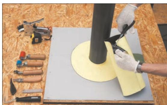
10. Снимите заготовку с трубы и закруглите ножницами нижний угол мембраны в нахлесте.
