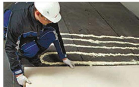
3. Укладывайте плиты LOGICPIR с легким прижимом. Старайтесь обеспечить максимальную ровность верхней плоскости плит для последующей приклейки к ним кровельной мембраны. Не наступайте на плиты сразу после приклейки к основанию!
