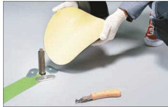
4. Вырежьте круглую заготовку из неармированной ПВХ мембраны V-SR (условно показана желтым цветом). Минимальный диаметр заготовки равен диаметру проходки плюс 150 мм. Для сохранения формы примыкания необходимо заполнить его утеплителем из каменной ваты.
