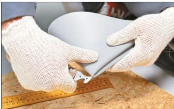
13. Сделайте отверстие с помощью кровельного ножа, для того чтобы найти центр окружности.
