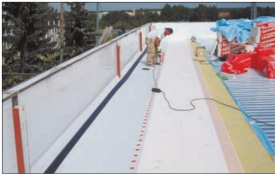
Рис. 3.5.17 Монтаж метровых рулонов ТЕХНОНИКОЛЬ
