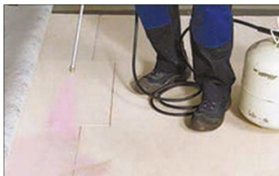
5. Через 3–5 часов после того, как пена наберет начальную прочность, приступайте к приклейке мембраны LOGICROOF FB к плитам LOGICPIR. Нанесите контактный клей на поверхность плит LOGICPIR.
