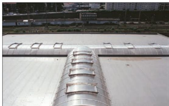
в действие устройства дымоудаления обеспечивают в случае пожара быстрый отвод дыма и тепла из здания. Это позволяет эффективно бороться с пожарами и максимально обезопасить людей, здания и ценное имущество (рис. 4.8.10).
