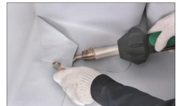
12. С помощью узкого латунного ролика приварите место перехода с нахлеста мембраны в «конверт».
