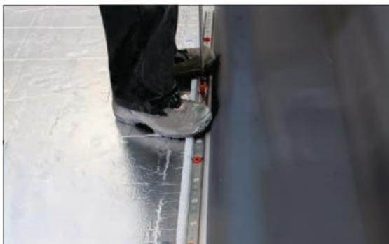
Стальная прижимная рейка применяется для крепления полимерной мембраны на кровлях с высокой ветровой нагрузкой. Рейка укладывается в шов между соседними рулонами мембраны либо поверх мембраны с установкой дополнительной заплатки шириной 20 см. Рейка крепится механически при помощи специальных полиамидных телескопов в сочетании с кровельными саморезами ТЕХНОНИКОЛЬ.
