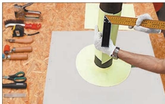
8. Вырежьте из неармированной мембраны V-SR полосу шириной 30–40 см. Длина полосы должна быть больше длины окружности трубы на 4 см, чтобы обеспечить нахлест для получения сварочного шва.
