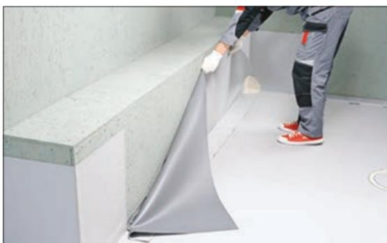
9. Поднимите свободный край заготовки на парапет.
