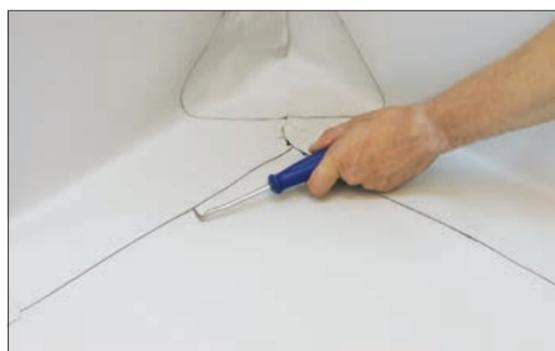
10. Проверяем качество швов при помощи чертилки.
