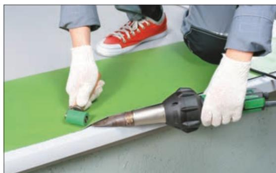
11. Приварите полосу к готовому элементу с помощью ручного фена. Проверьте пробником все швы, особенно тщательно — место нахлеста армированной мембраны к неармированной мембране.
