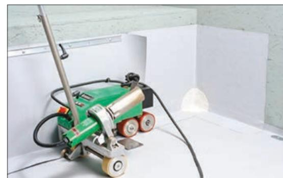
17. Закруглите все углы. Приварите полосу к основному кровельному коврику при помощи автоматического оборудования.
