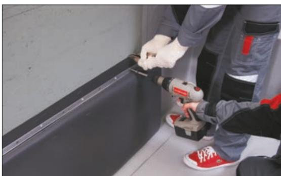
11. Поместите дополнительную рейку в карман. При закреплении крайнего крепежа тяните мембрану за угол по диагонали, чтобы избежать образования волны.
