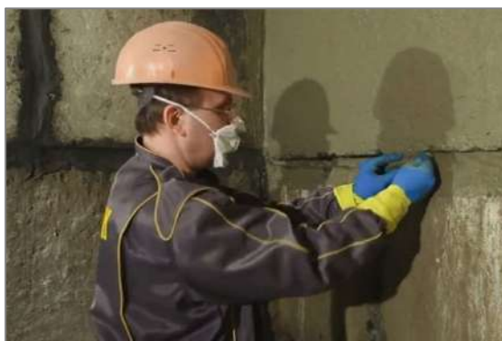
Рисунок 4.2 – Заделка швов между сборными конструкциями составом ilmax express монтаж
