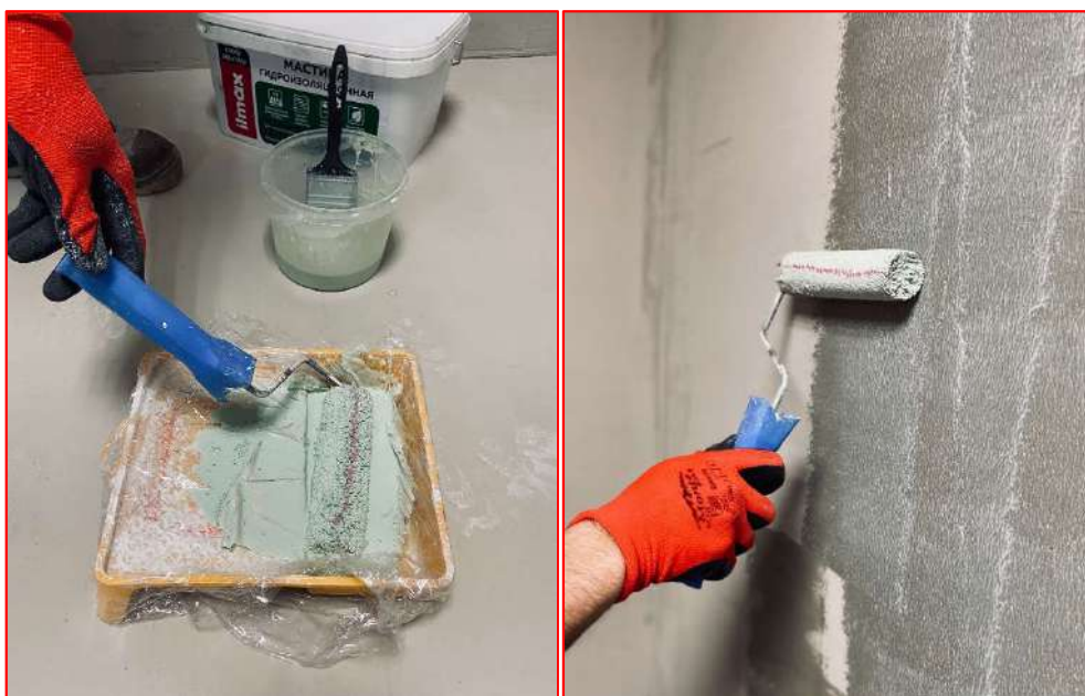
Рисунок 4.11 – Грунтование основания под гидроизоляцию ready aquastop
