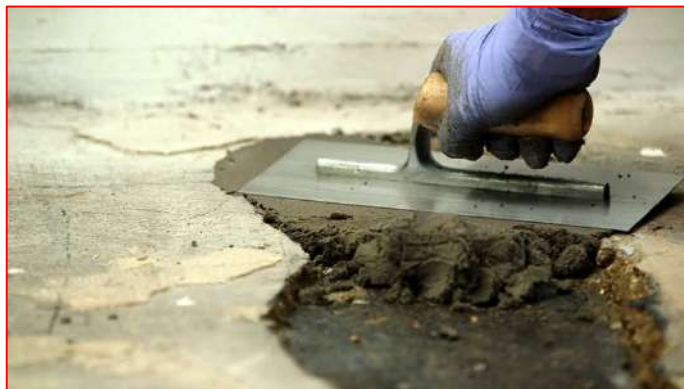
Рисунок 4.6 – Заделка выбоин и впадин
