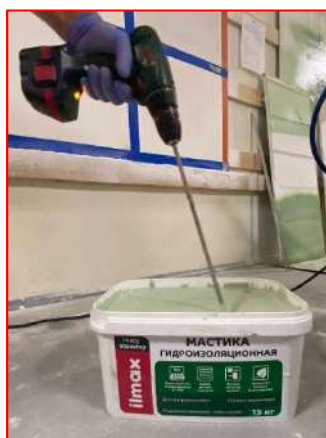
Рисунок 4.19 – Перемешивание состава ilmax ready aquastop
