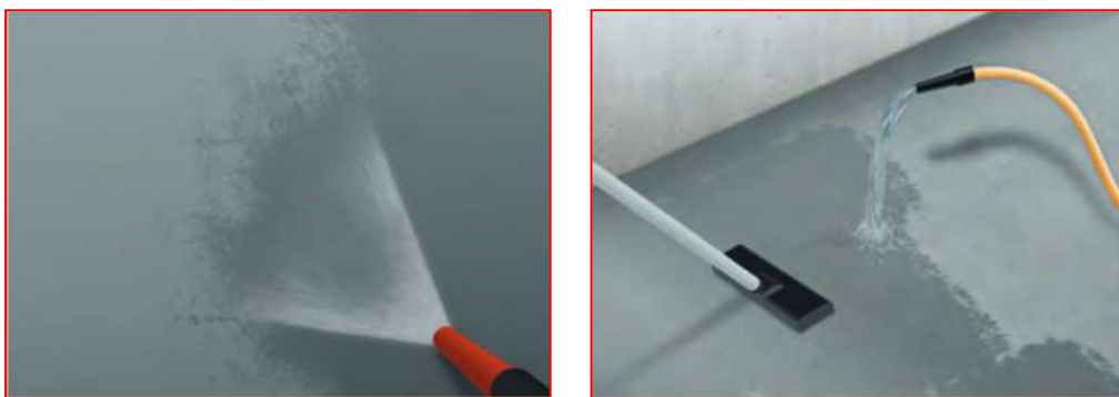
Рисунок 4.8 – Увлажнение основания перед нанесением гидроизоляции ilmax protect проникающей
