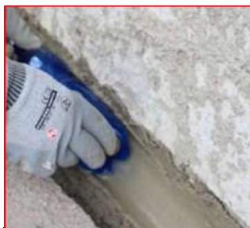
Рисунок 4.16 – Устройство галтели
