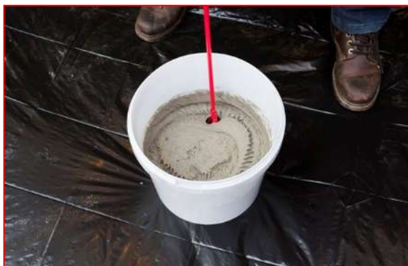
Рисунок 4.7 – Приготовление состава из сухой смеси и воды
