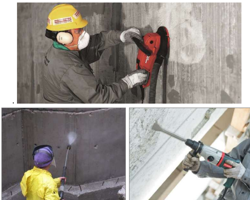
Рисунок 4.1 – Очистка бетона
