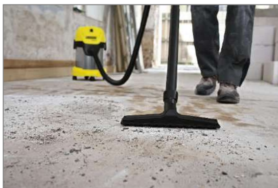
Рисунок 4.3 – Обеспыливание поверхности пылесосом
