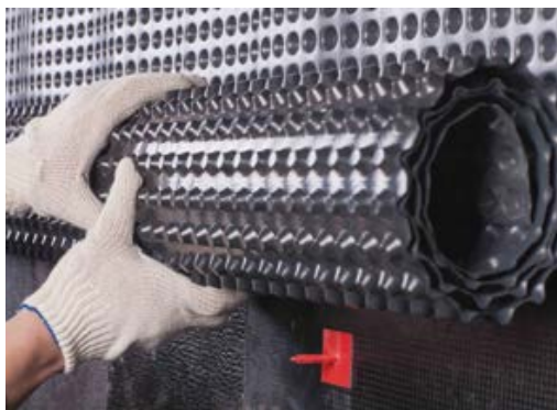
Защита гидро- изоляции
